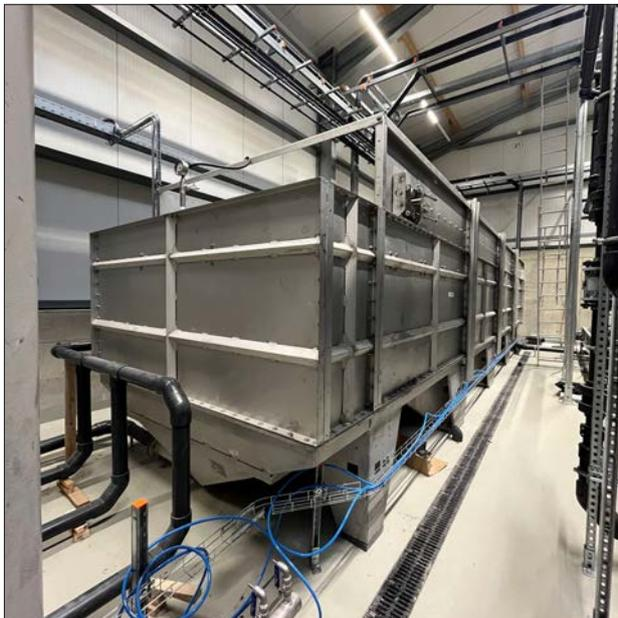
*La fase líquida residual se vierte en un recipiente de flotación de acero inoxidable. Las partículas pequeñas y las sustancias en suspensión reaccionan y se depositan en el fondo. Este lodo se retorna de nuevo al proceso de preparación. Los componentes sólidos restantes de la fase líquida se eliminan mediante filtrado.*
