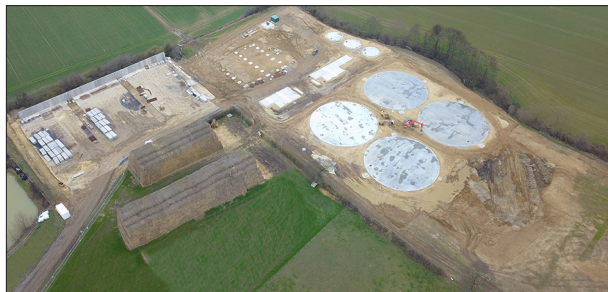
El fabricante de plantas de biogás alemán WELTEC BIOPOWER empieza en este invierno la construcción de una planta de biometano en Pontefract, en el condado de West Yorkshire. El cliente y explotador de la planta es Lanes Farm Energy.
