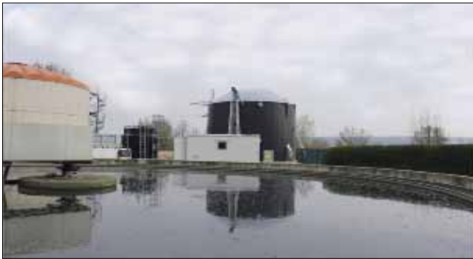
Hace poco se pudo poner en funcionamiento un nivel anaerobio de WELTEC en una estación depuradora de aguas residuales en el sur de Alemania.
