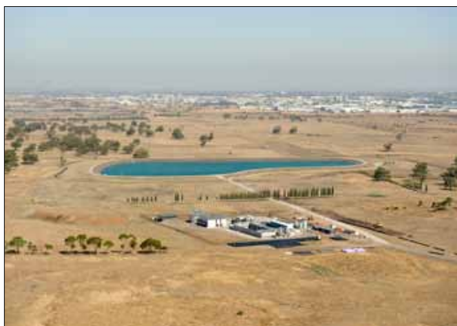
Junto con su socio del proyecto Aquatec Maxcon, el fabricante alemán de plantas de biogás WELTEC BIOPOWER construirá una planta de biogás a las afueras de Melbourne.
