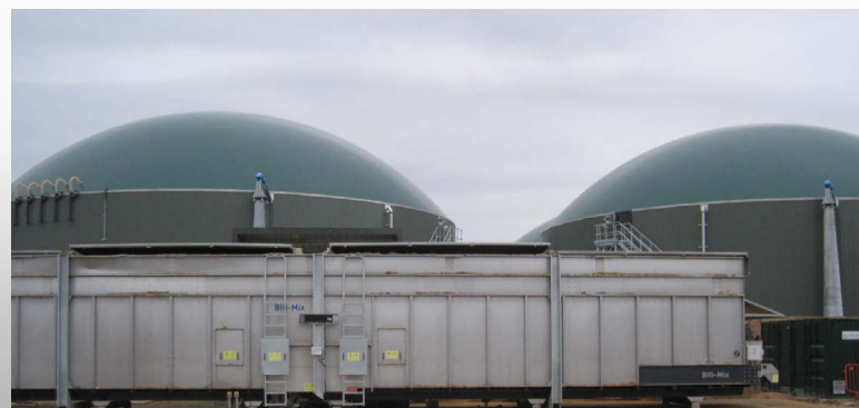
Dos dosificadores de fondo de empuje con un MULTIMix cada uno se encargan del llenado continuo de los fermentadores
